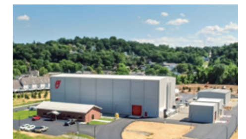
クライオポンプのテストスタンド外観
